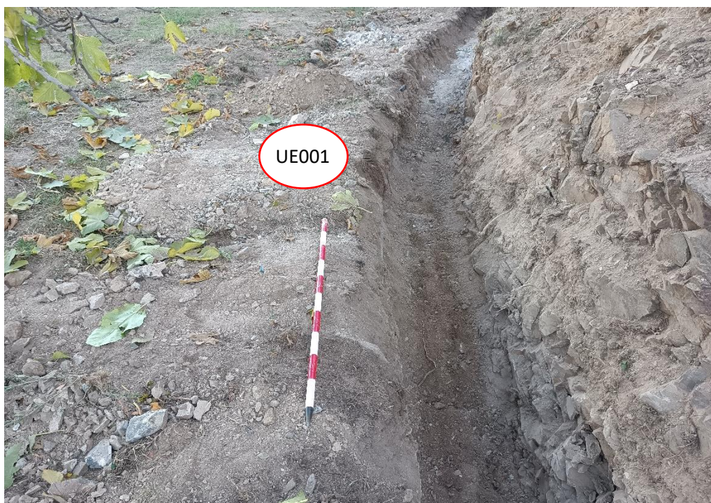
Fig. 05. Rasa realitzada amb màquina
